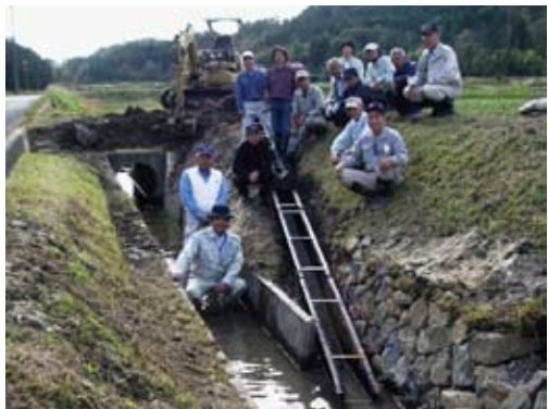
世羅町田打地区の水路と田んぼを結ぶ水田魚道
