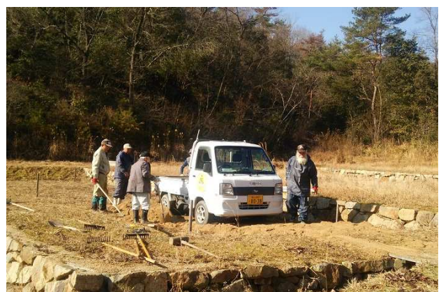
↑ハウスを設置するために自然観察園の湿生花園の一部を整地しました。
