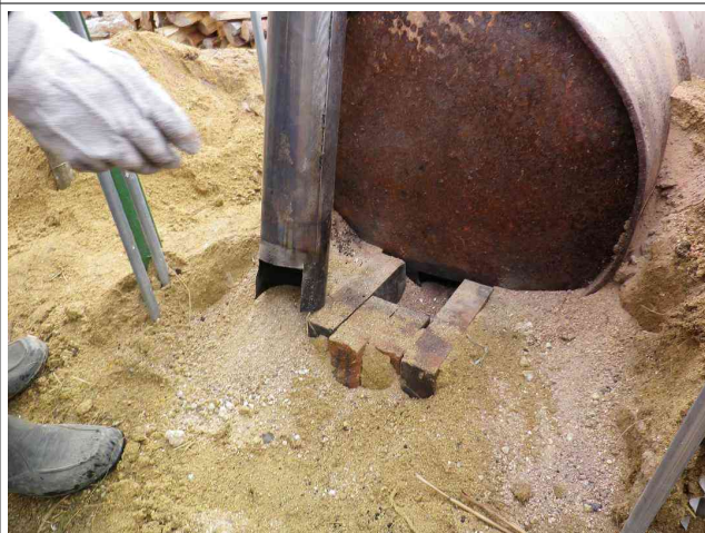
煙突の取り付け口のようす
